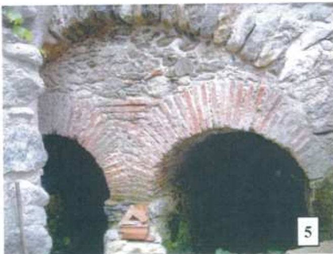
Moulin seigneurial Sortie de deux tunnels (voir figure 1)
