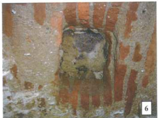
Moulin seigneurial Ouverture dans la voûte du tunnel Est (voir figure 1)
