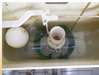
mise en place de de plaquette WC pour réduction des volumes de chasse
